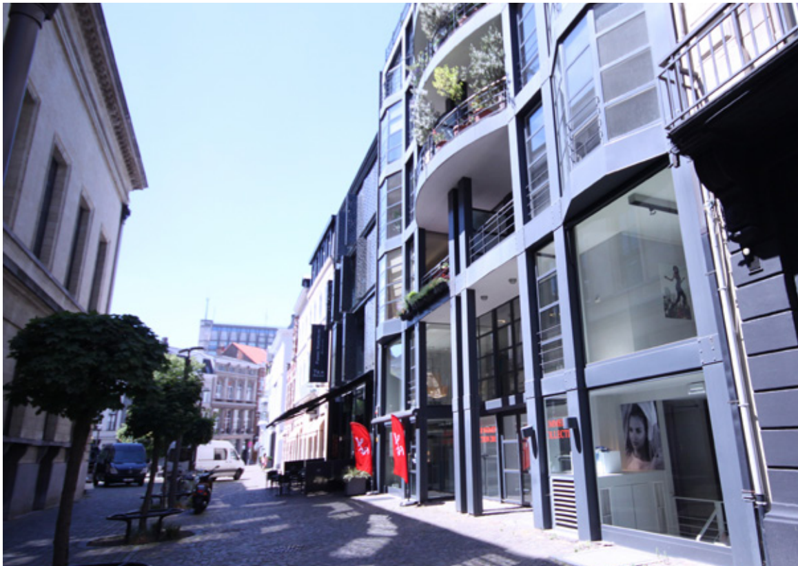
Antwerpen, Schuttershofstraat 22 doorlopend naar de Kelderstraat
